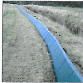
Barrière permanente unidirectionnelle permettant aux amphibiens de sortir (plan incliné) mais pas de rentrer dans la zone chantier. Source Herpetosure, 2009
