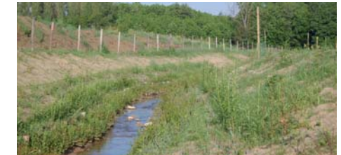
5 mois après les travaux de dérivation
