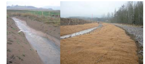
Photographie – Technique végétale sur cours d'eau En cours de travaux de dérivation et à la fin des travaux
