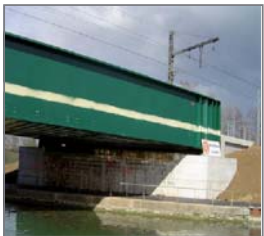
Exemple de franchissement d'un cours d'eau
