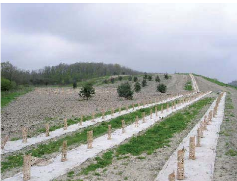
Plantation d'une lisière boisée en sommet de déblai asymétrique – LGV Est - 2007
