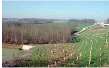
Insertion d'un bassin de rétention et de remblais d'accroche – Passage Grande Faune (PGF) des Rochets (77) - LGV Est – 2007
