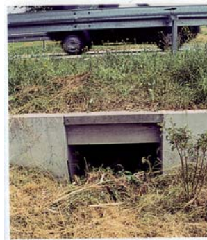
Dalot – batrachoduc à double sens de circulation et différentes formes d'obstacles collecteurs de type cornières préfabriquées (source : Carsignol J., 2005)
