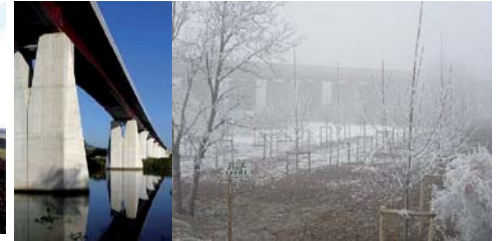
A gauche : viaduc de la Moselle LGV Est – 2007.
