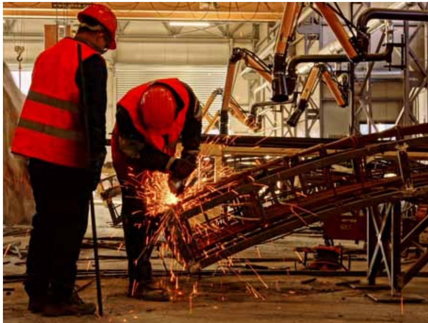
Saint-Martin-la-Porte Fabrication d'un voussoir
