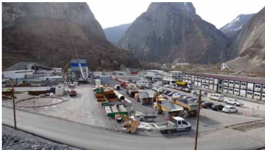
Saint-Martin-la-Porte Plateforme du chantier
