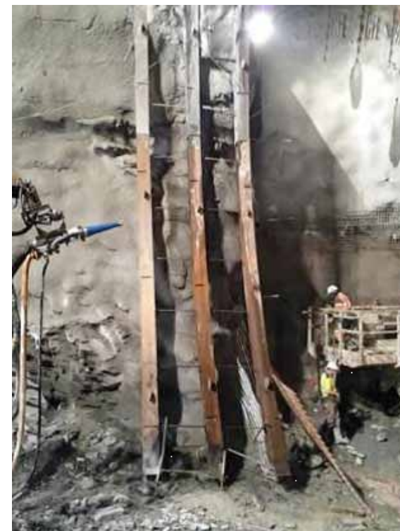
Saint-Martin-la-Porte Rampa d'accès : Pose cintres HEB et bétonnage de remplissage de cintres
