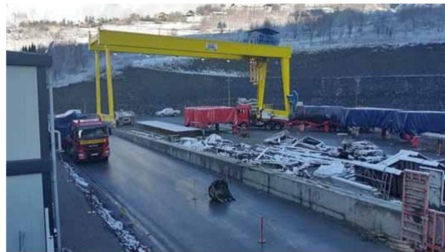
Saint-Martin-la-Porte Plateforme – Livraison tête de coupe du tunnelier
