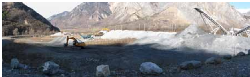
Saint-Martin-la-Porte Site de dépôt de Saint-Félix
