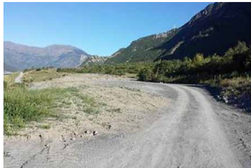
Dépôt de Babylone Amenée terre végétale, pose et étalement
