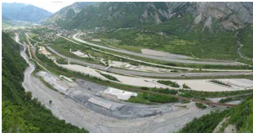
Saint-Julien-Montdenis Site de dépôt d'Ilaz
