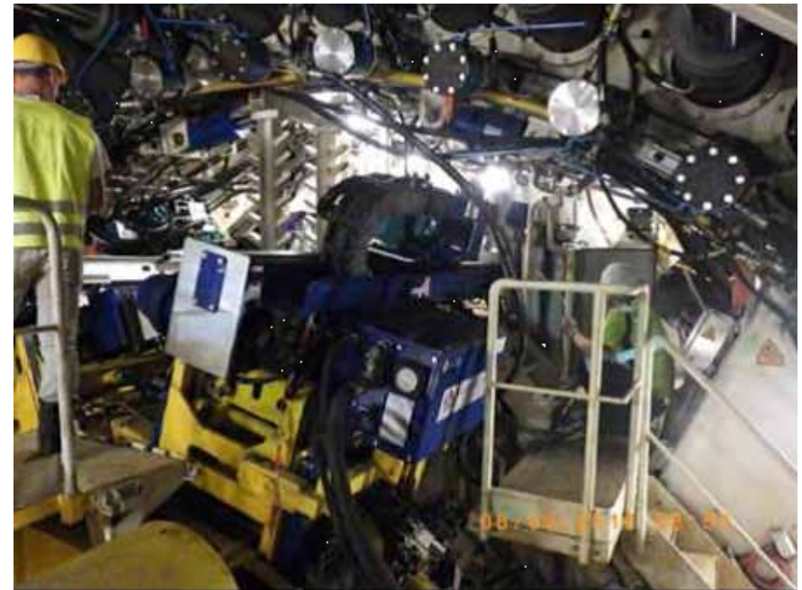
Saint-Martin-la-Porte Montage tunnelier : Foreuse
