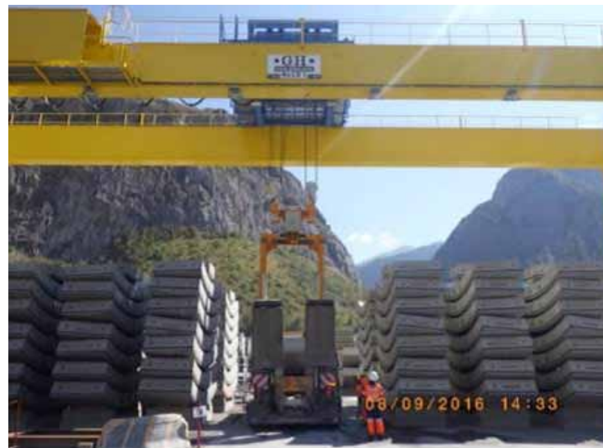
Saint-Martin-la-Porte Plateforme Saussaz : Stockage voussoirs
