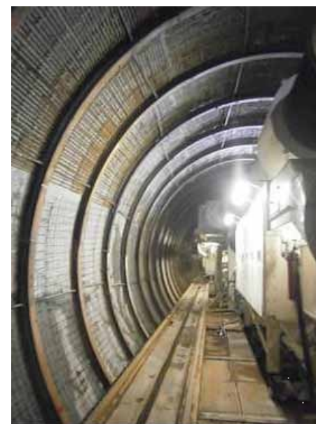
La Maddalena Soutènement de la galerie par cintre et trellis
