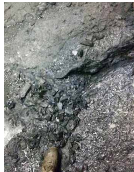
La Maddalena - pk 4.290 m Faille avec venue d'eau
