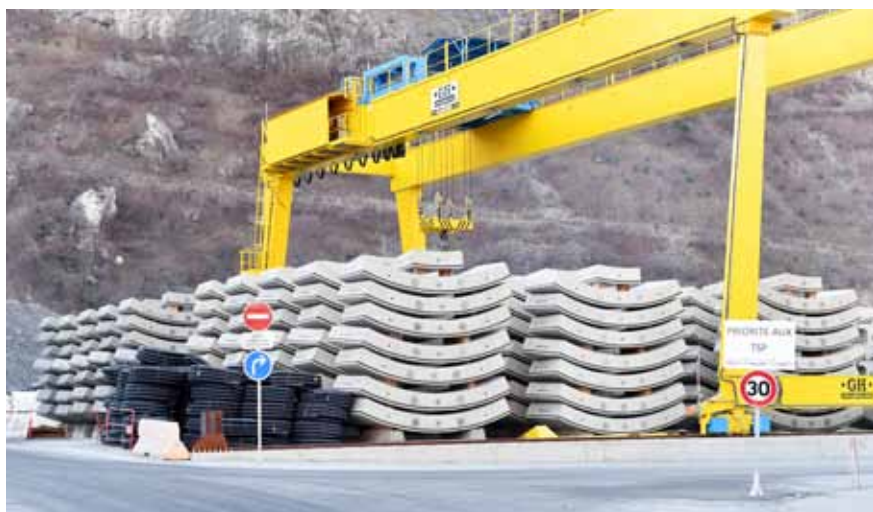
Saint-Martin-la-Porte Voussoirs stockés sur la plateforme
