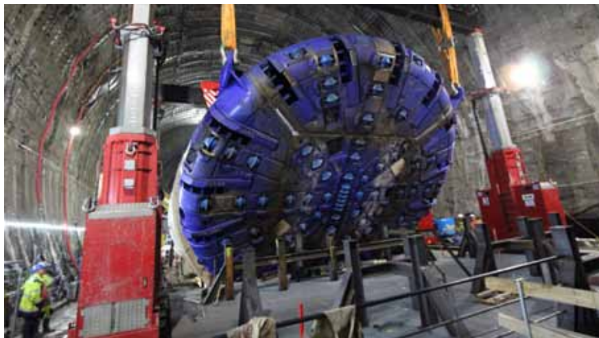
Saint-Martin-la-Porte Montage du tunnelier
