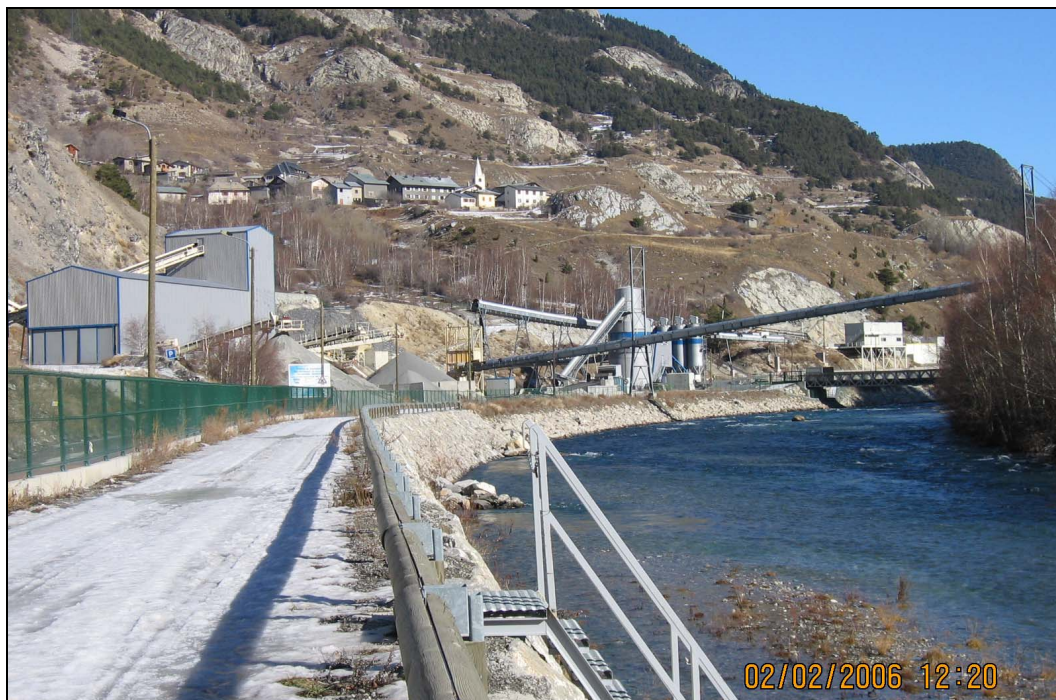
Figure 3 Le chantier Villarodin-Bourget a Modane a coté de l'Arc.
