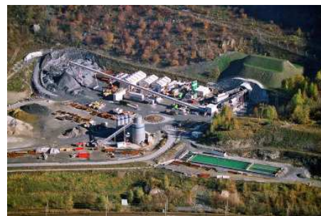
7. Vue extérieure du chantier de la descenderie de Saint-Martin-la-Porte ( début 2010)
