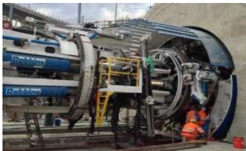
8. Mise en place du tunnelier dans la galerie de La Maddalena (novembre 2013)
