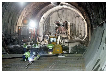
9. Consolidation du front par boulonnage à Saint-Martin-la-Porte et réalisation du radier (nov. 2009)
