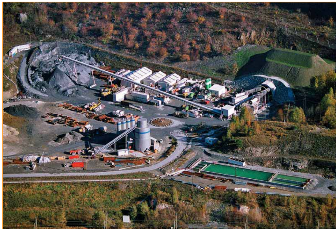
Plateforme de chantier à Saint-Martin-la-Porte. © J.L Viart - Modane.
