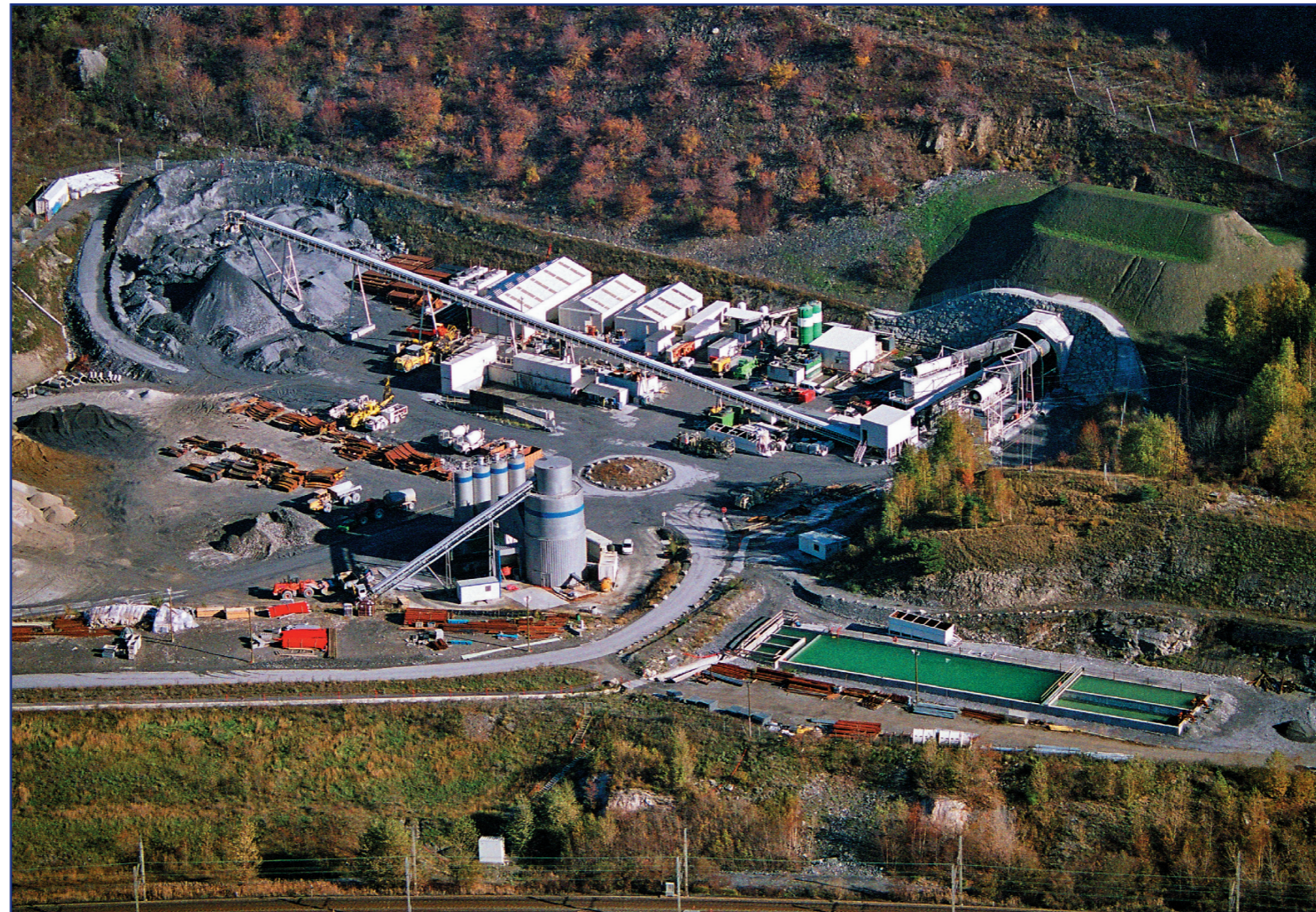
Chantier du Plan des Saussaz – Saint-Martin-la-Porte. © J.L Viart - Modane.
