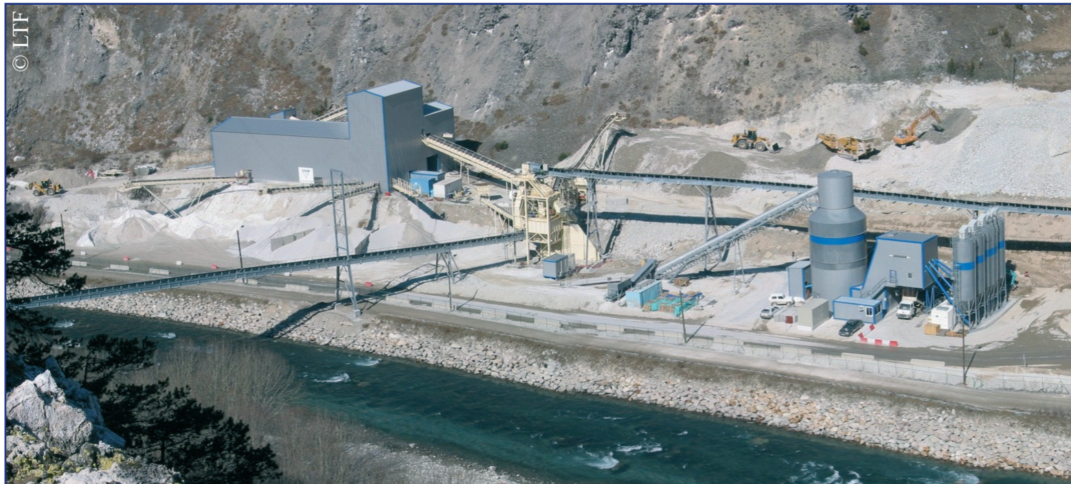
Chantier de Modane – Villardodin-Bourget : station de traitement des matériaux et centrale à béton.
