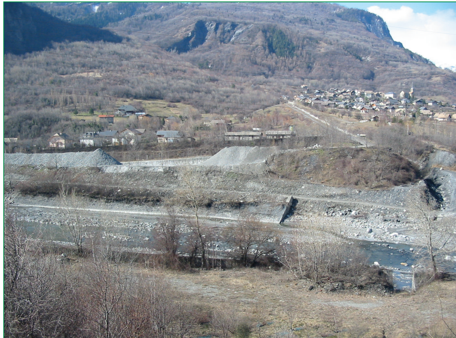
Zone de chantier des Resses d'en Bas.
