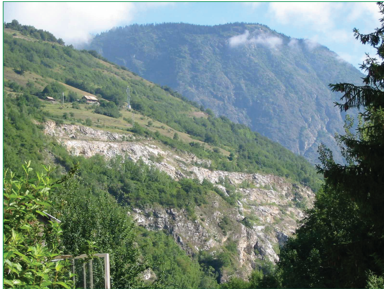
Site de dépôt de la Combe des Moulins.
