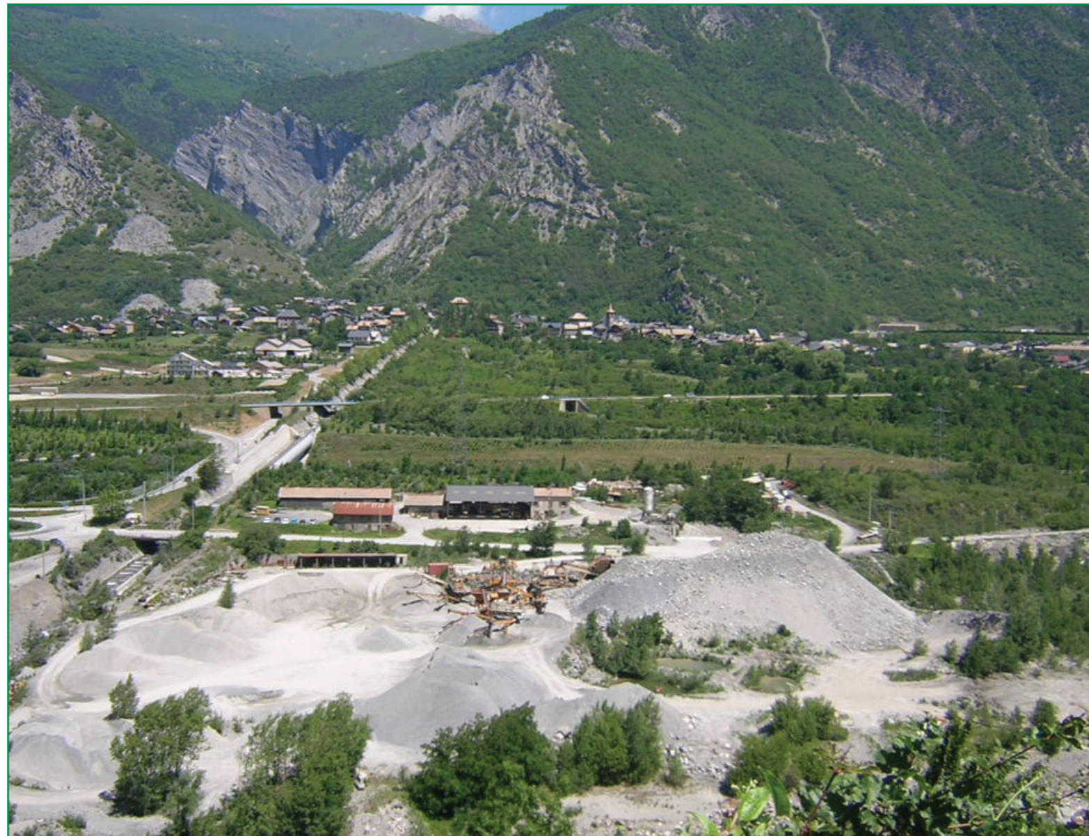
Zone de chantier du Saint-Julien (Scetauroute).
