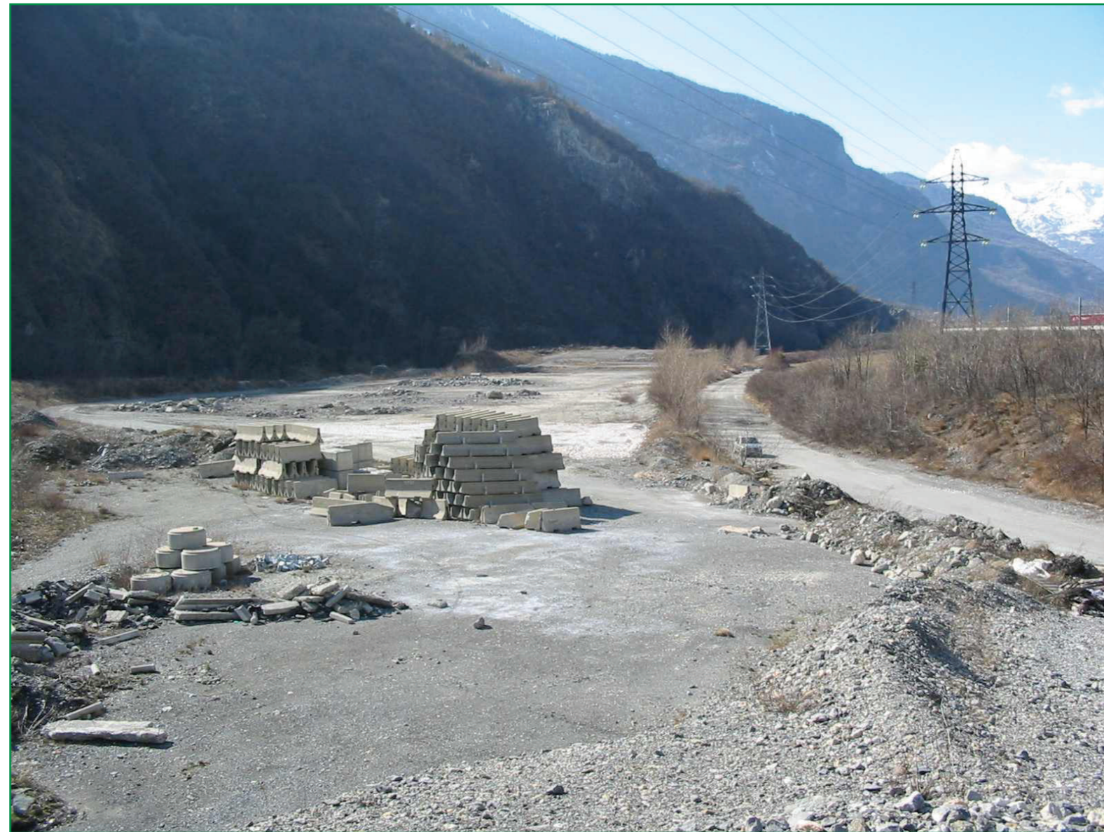
Zone de chantier de l'Illaz.
