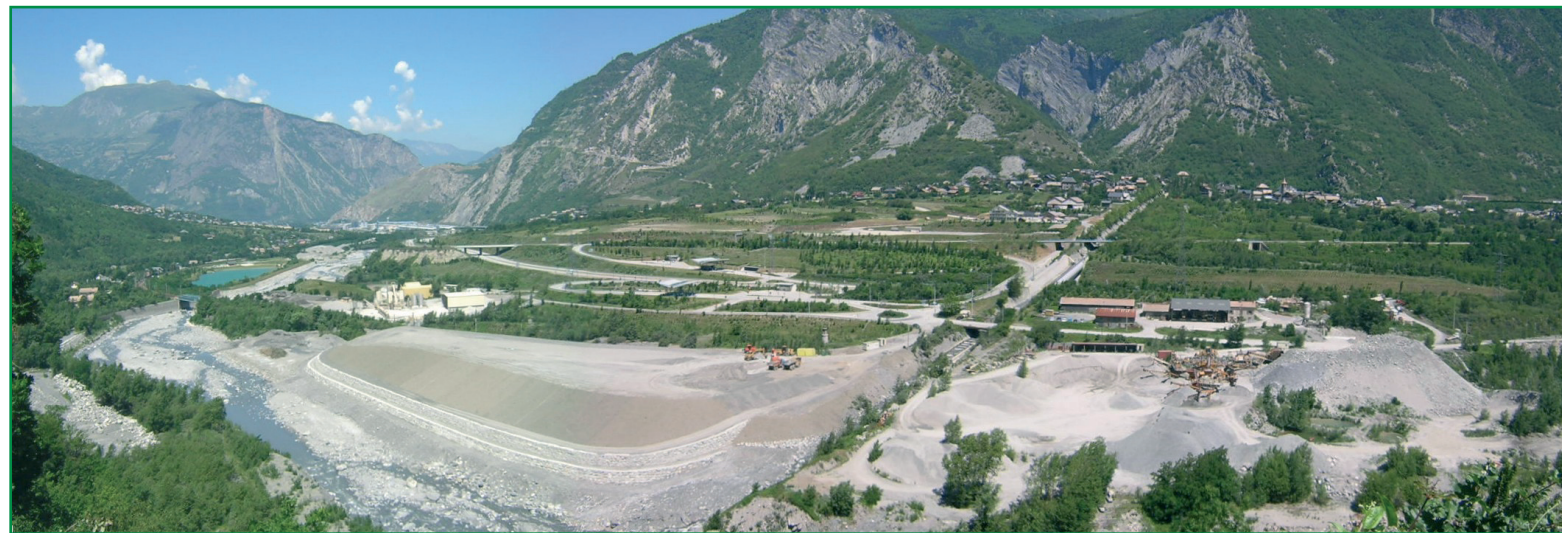
Site de la bande transporteuse Sous-Villard-Clément – Saint-Julien (20 juin 2005). Au premier plan : site de Saint-Julien et dépôt modelé. Au fond, à gauche : Saint-Jean-de-Maurienne (Scetauroute).
