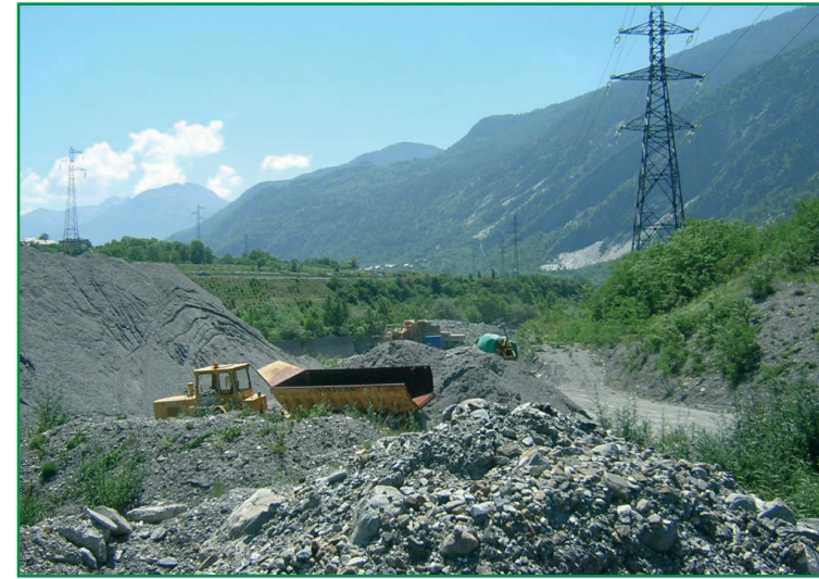
Site de chantier des Resses d'en Bas (20 juin 2005). Au premier plan : stockage de granulats. En arrière-plan : le site de dépôt des Resses (Scetauroute).
