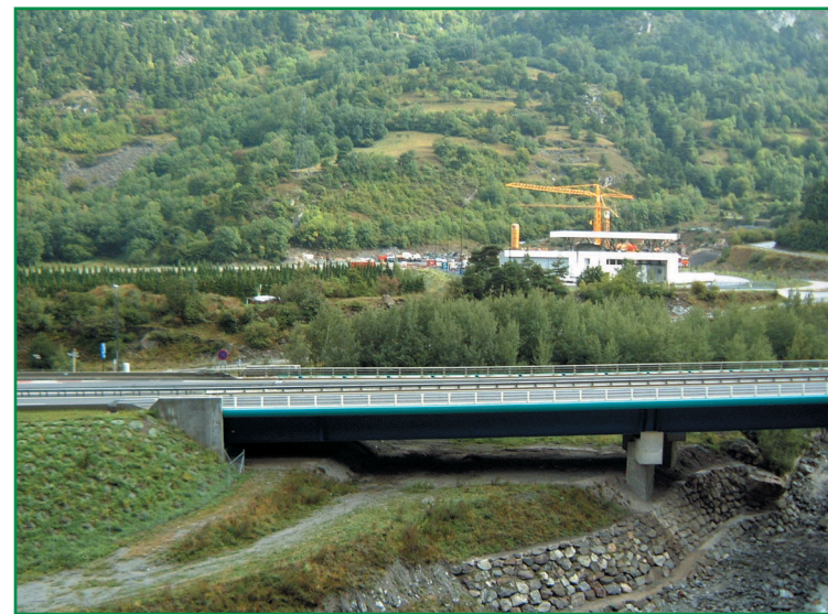
Site de chantier des Sarrazins.
