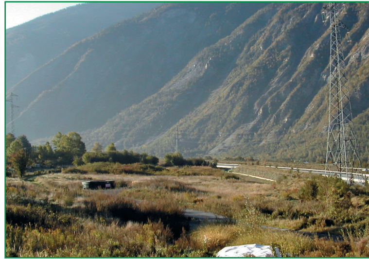
Site de chantier de Villard-Clément.
