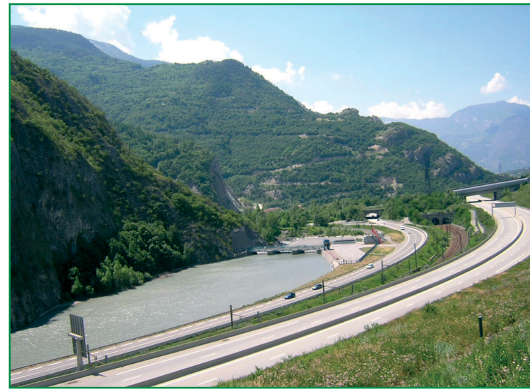
Site de la bande transporteuse entre Plan des Saussaz et Saint-Félix (Scetauroute, 20 juin 2005). De gauche à droite : l'Arc, la RN6, la ligne historique et l'A43. Au centre : le barrage sur l'Arc au droit de Saint-Martin-la-Porte. À droite et en arrière-plan : le ruisseau du Saint-Bernard passant au-dessus de l'A43.
