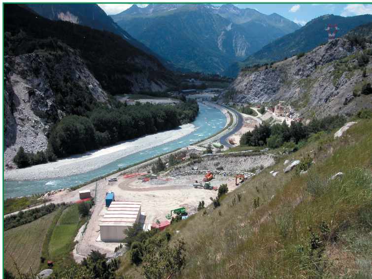
Site de chantier de Modane-Villarodin-Bourget.
