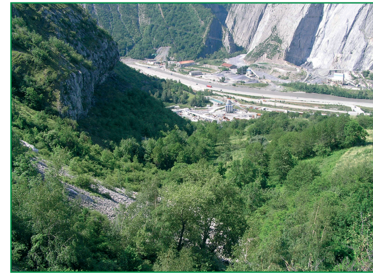
Site d'accès entre Plan de Saussaz et La Porte (Scetauroute, 23 juin 2005). Au centre : le site d'attaque intermédiaire de Plan de Saussaz. En arrière-plan : la carrière Calypso.
