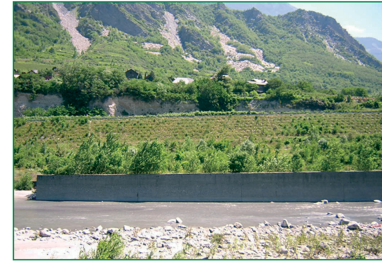
Sous-Villard-Clément vu depuis la rive gauche de l'Arc (20 juin 2005). Au premier plan : l'Arc canalisé. En arrière-plan : le site de chantier de Sous-Villard-Clément (Scetauroute).
