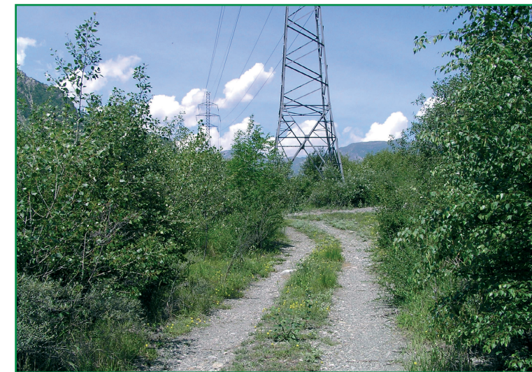
Site de la bande transporteuse Saint-Julien – Plan d'Arc (23 juin 2005). Au centre : pylône électrique de la ligne 2 x 42 / 63 kV La Saussaz – Echaillon – Montricher (Scetauroute).
