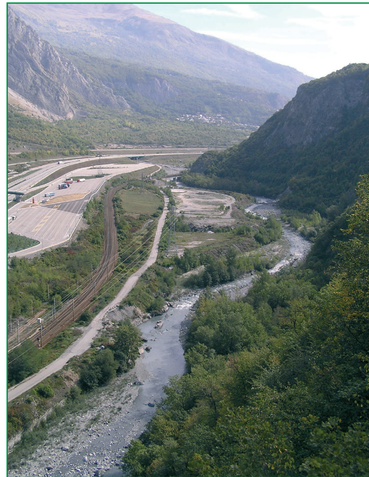
La zone de chantier d'Illaz (Scetauroute juin 2005).
