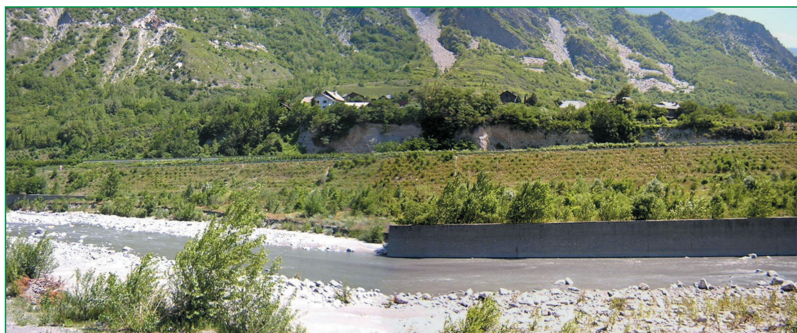
La zone de Sous-Villard-Clément – Scetauroute (20 juin 2005).
