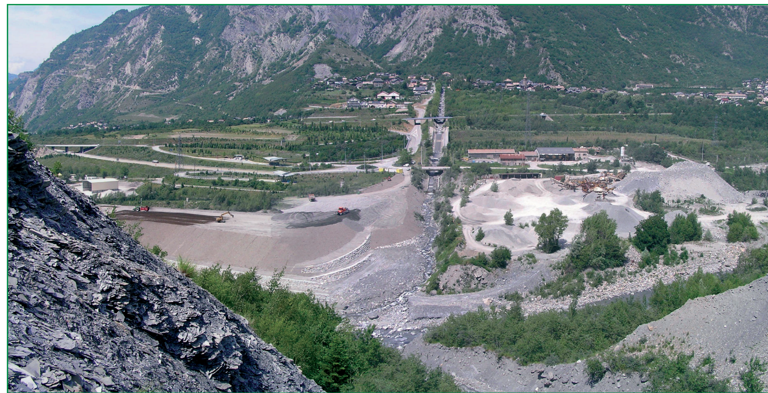
Zone de Saint-Julien au niveau de la confluence du Bochet et du Saint-Julien avec l'Arc (Scetauroute – 21/06/05).
