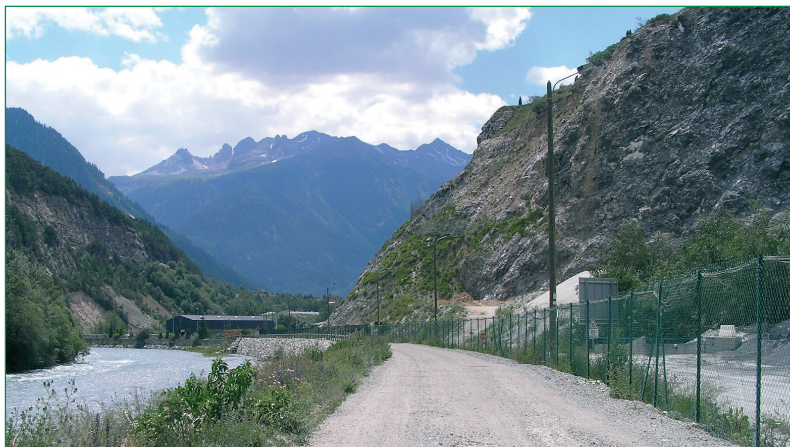
Piste actuelle en rive droite de l'Arc et ancien emplacement de la voie ferrée désaffectée (Scetauroute – 21/06/05).
