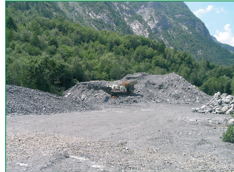
Le site entre Saint-Julien et le dépôt des Resses (Scetauroute – juin 2005).
