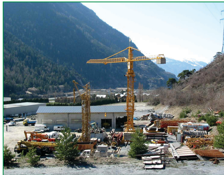
Site d'attaque intermédiaire des Sarrazins entouré par le terrain de foot, l'entreprise Casarin, la SFTRF et le lotissement EDF.
