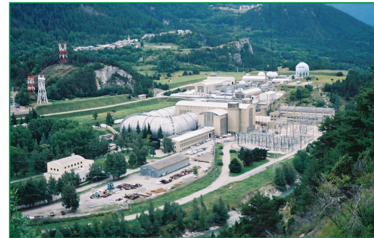
Usine hydroélectrique EDF et soufflerie de l'ONERA sur les communes d'Avrieux et de Villarodin-Le Bourget.
