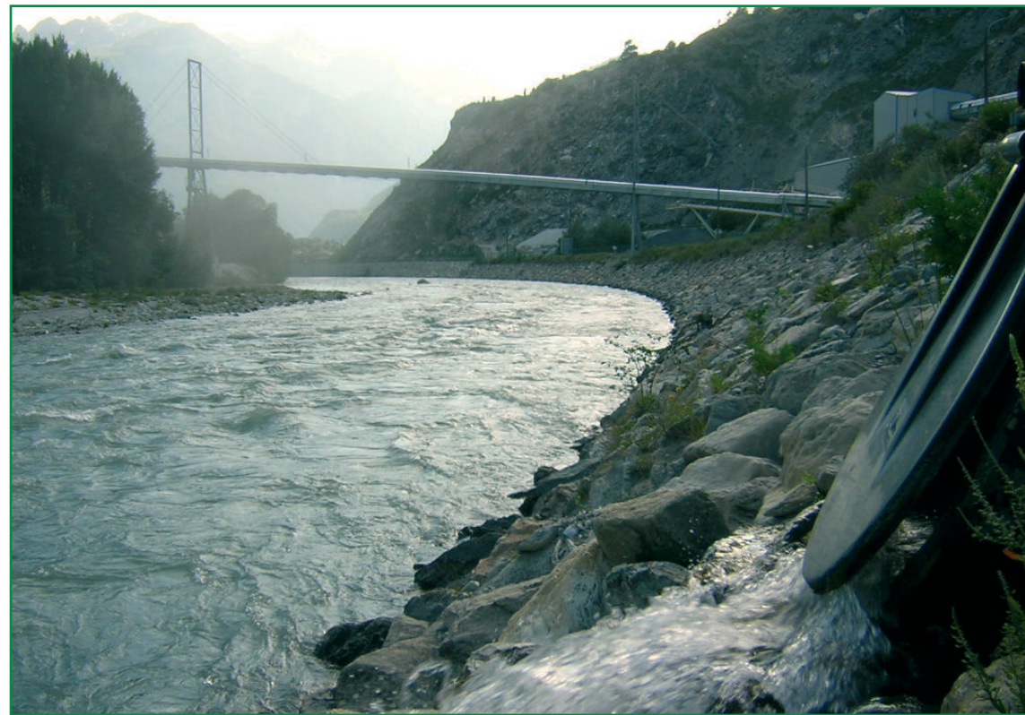
Protection des berges par enrochements sur la partie ouest du site d'attaque (Scetauroute 20/06/05).
