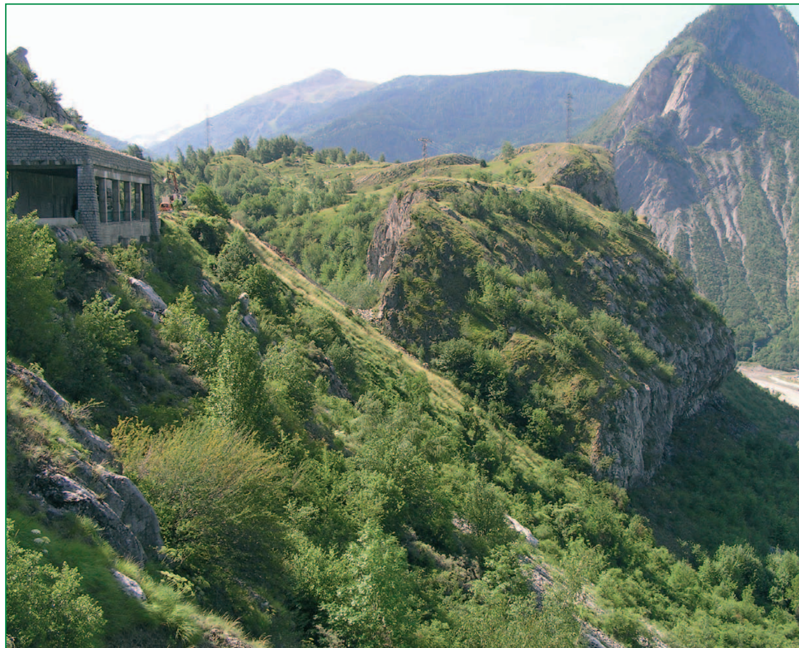
Site de dépôt de La Porte, en contre bas le site d'attaque intermédiaire du Plan des Saussaz(Scetauroute 23/06/05).
