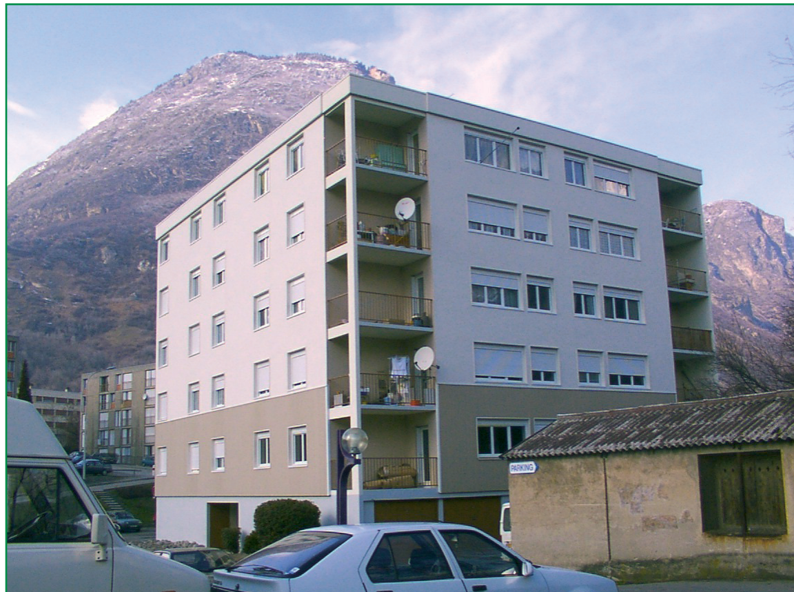
Habitat collectif à Saint-Jean-de-Maurienne (Scetauroute 19/02/04).
