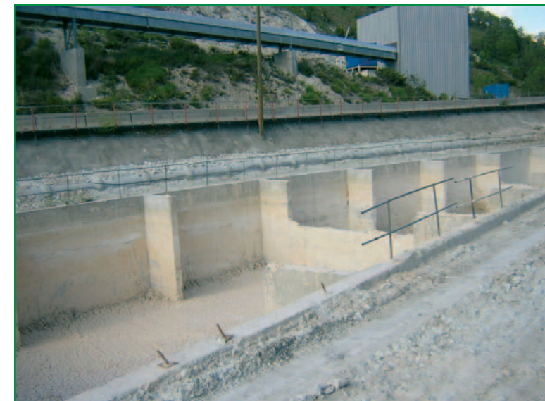
Bassin de décantation des eaux d'exhaure utilisé lors des travaux de la descenderie de Modane (Scetauroute 20/06/05).
