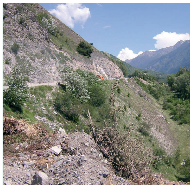
Vue sur la RD 219 (Scetauroute 20/06/05).
