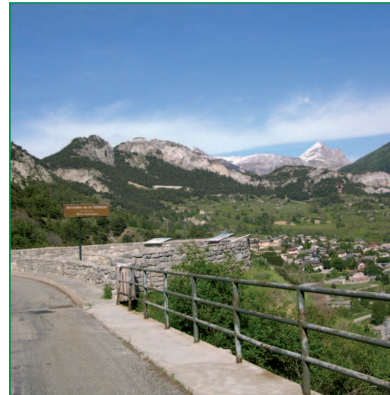
Vue de l'usine de ventilation depuis le belvédère de la Tournaz (Ar.thème Associés).
