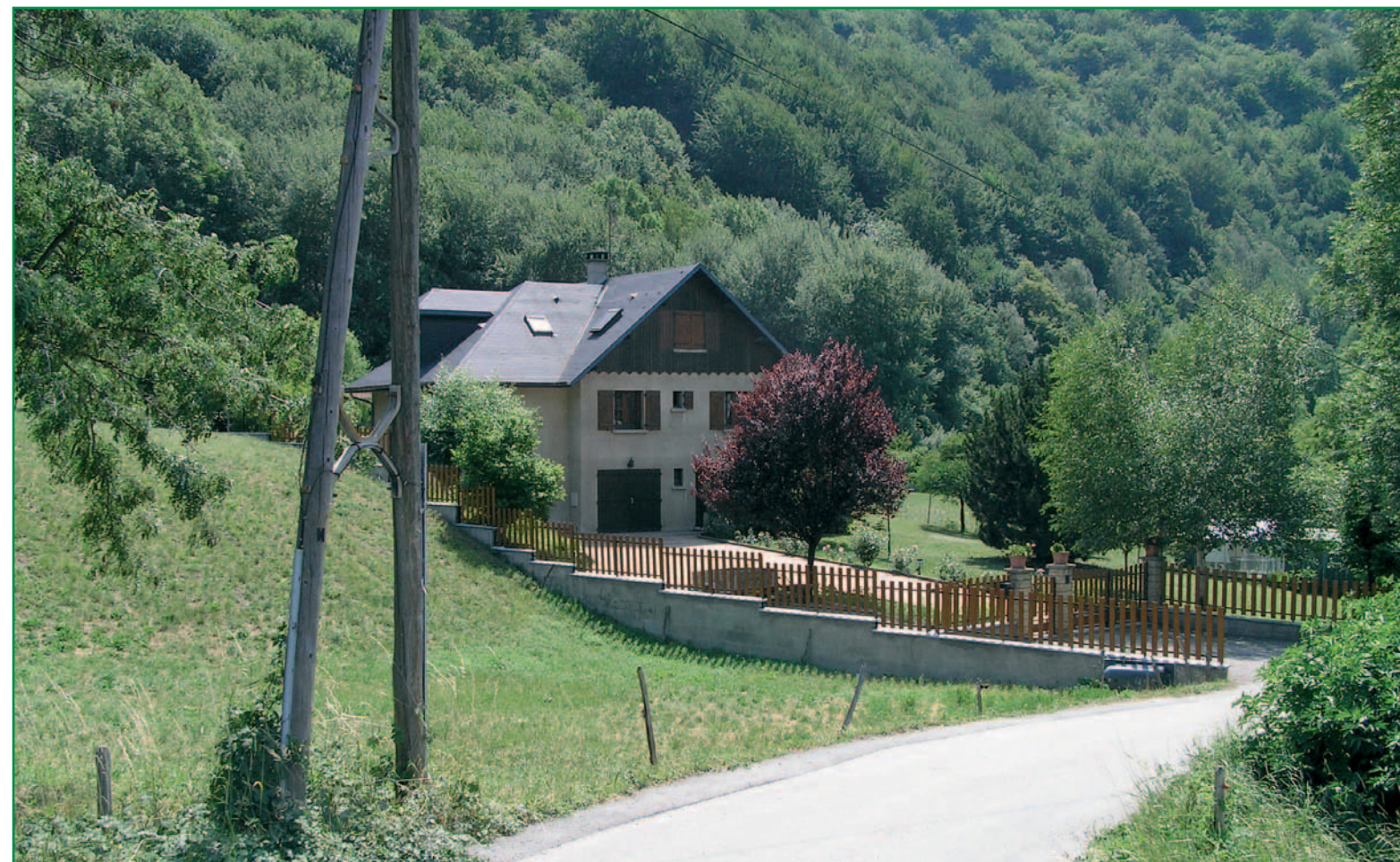
Quartier des Nouvelles Resses (Scetauroute 23/06/05).
