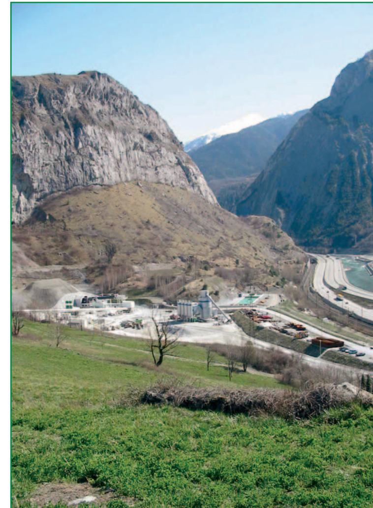
La zone de chantier au pied du versant rocheux abrupt de l'adret.
