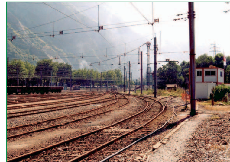
Effet de coupure existant au niveau de la zone de maintenance (Scetauroute).
