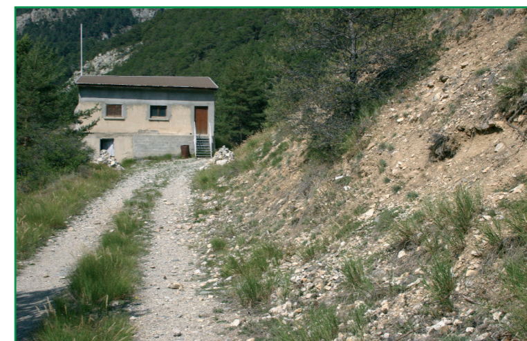
Chemin et talus à cailloutis.
