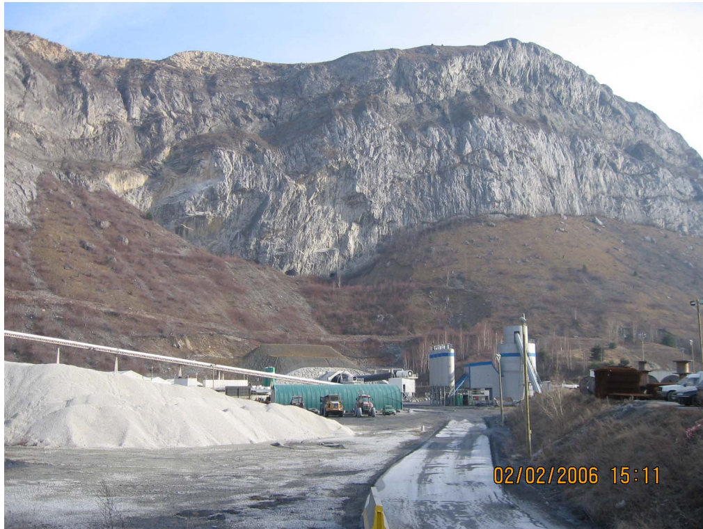
Figure 4 Chantier de St Martin de La Porte
