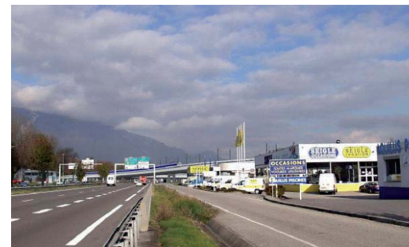
Vue depuis la VRU vers le Nord
