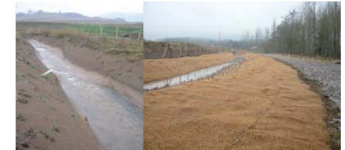
Photographie – Technique végétale sur cours d'eau En cours de travaux de dérivation et à la fin des travaux
