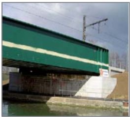
Exemple de franchissement d'un cours d'eau
