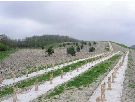
Plantation d'une lisière boisée en sommet de déblai asymétrique – LGV Est - 2007
