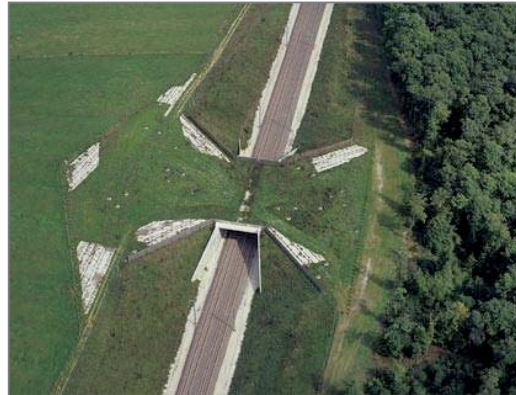
Passage grande faune sur la LGV Est (source RFF)
