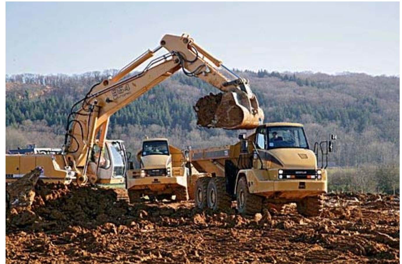
Camion au chargement – Geneuille (RFF, LGV Rhin-Rhône branche est)
