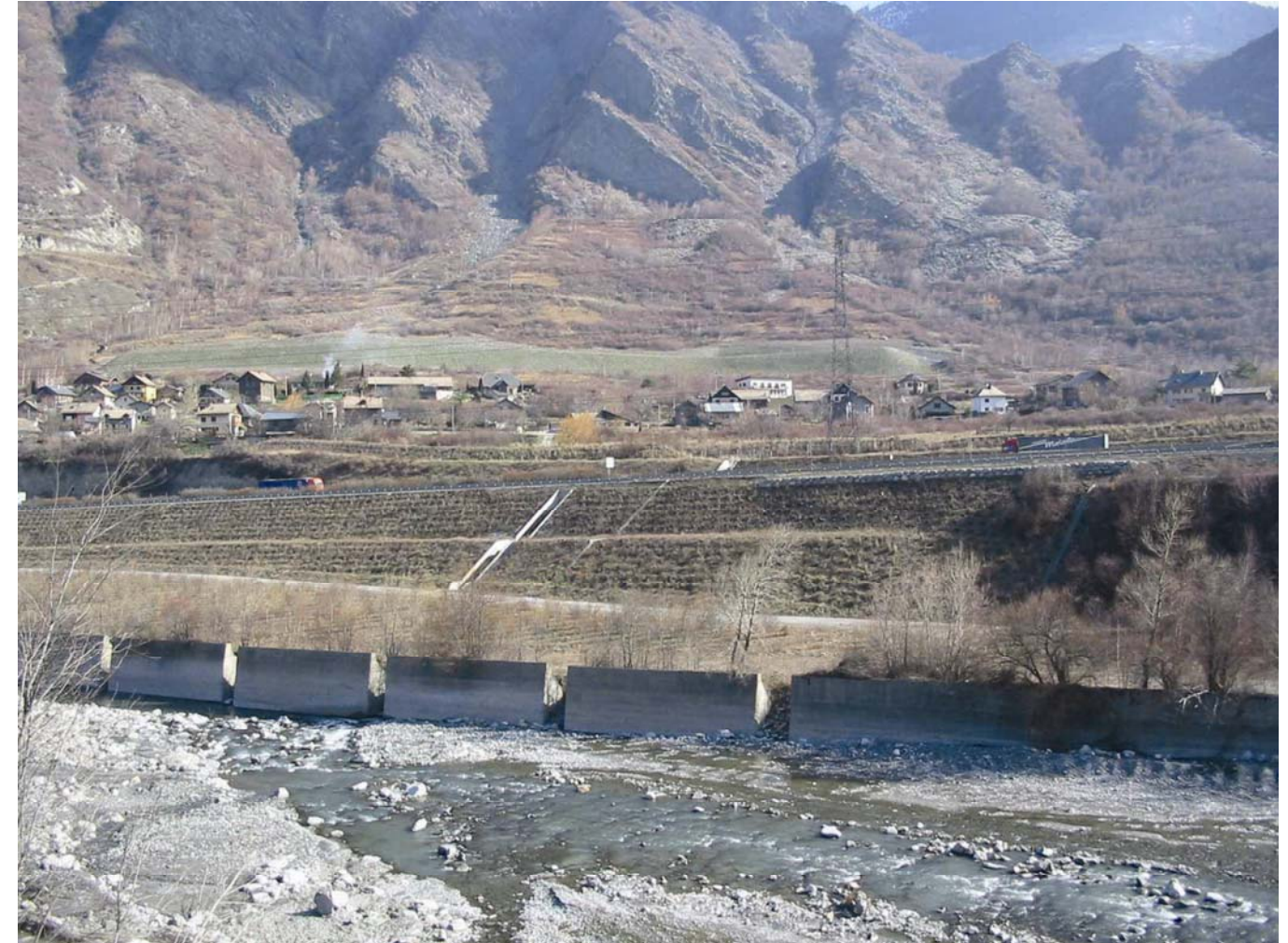
Dispositif de mur crénelé au droit de Sous-Villard-Clément
