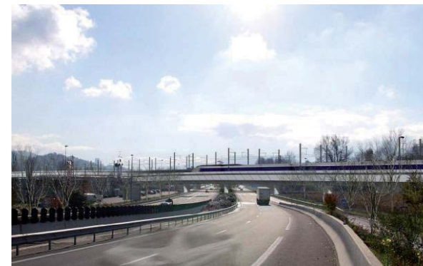
Vue depuis la RN 201 / VRU en direction du Sud, au droit du Carrefour de Villarcher.
