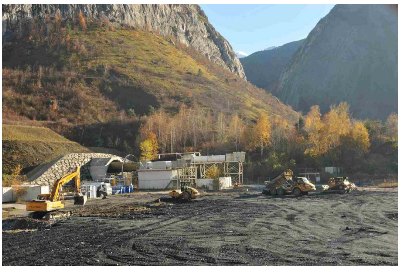
LTF – aménagement du chantier de Saint Martin la Porte
