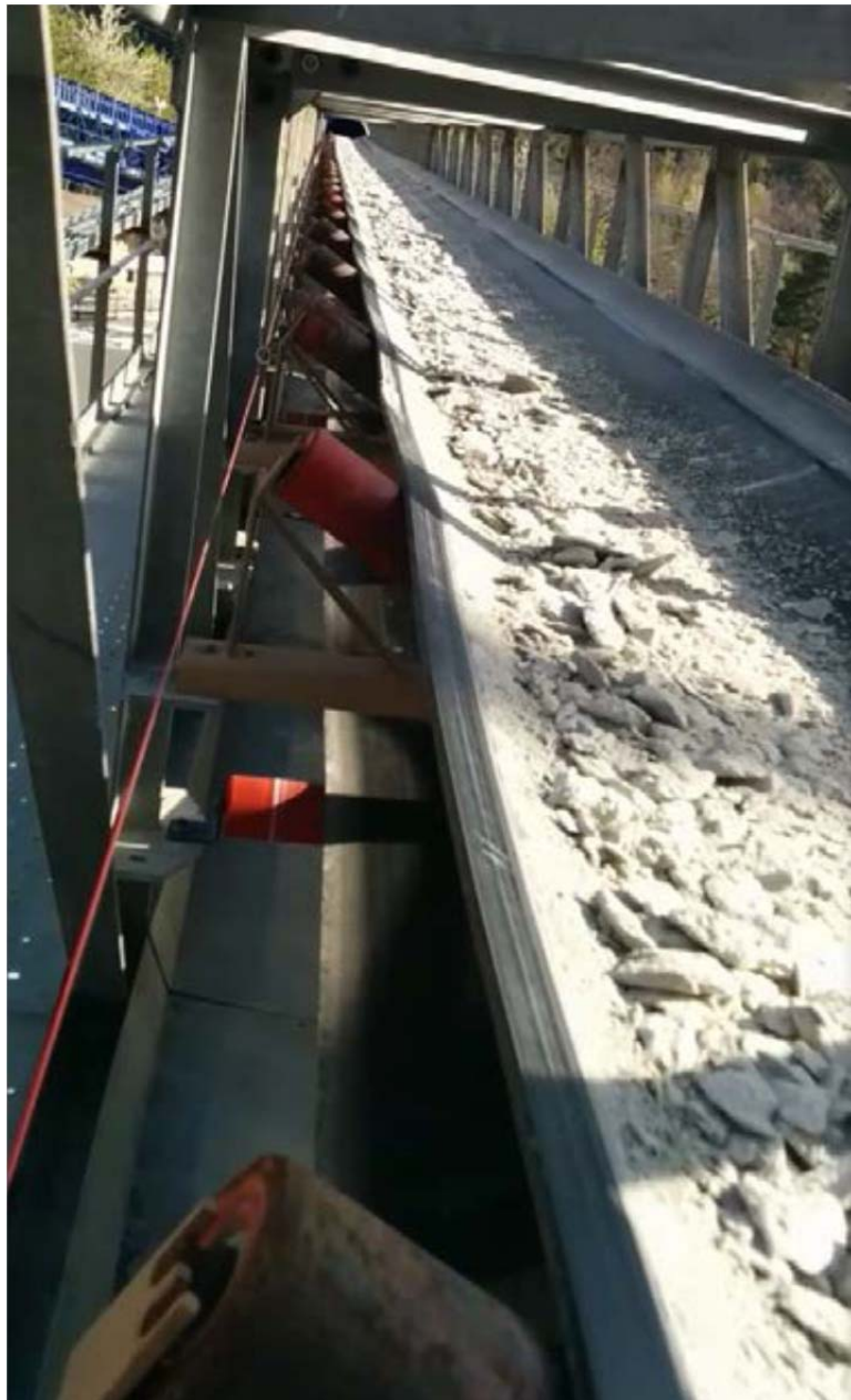
LTF - chantier de La Maddalena : Déblais évacués par bande transporteuse
