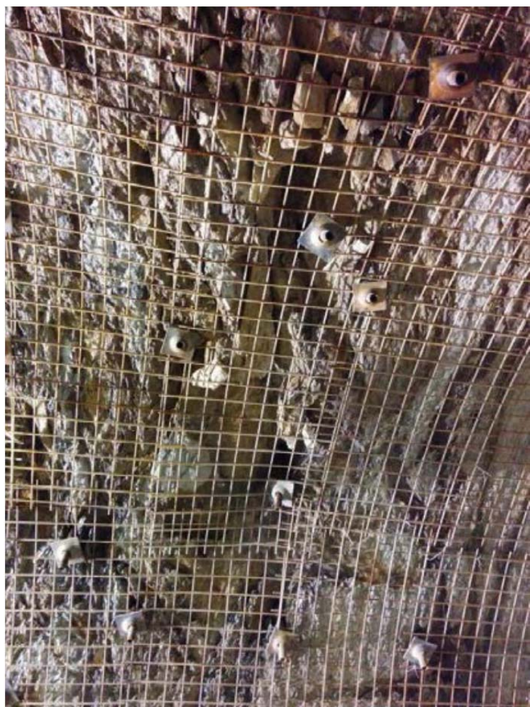
LTF - chantier de La Maddalena : Confortement boulons + treillis soudé au niveau d'une zone rocheuse fracturée
