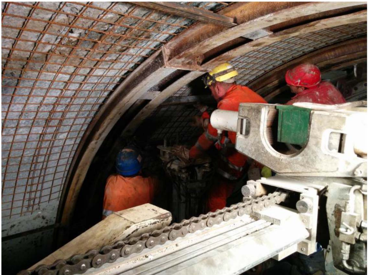
LTF - chantier de La Maddalena : Installation d'un cintre
