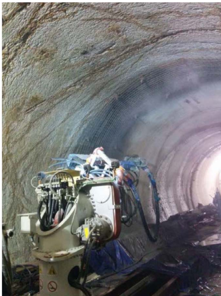
LTF - chantier de La Maddalena : Mise en œuvre de renforcements en béton projeté au niveau de zones rocheuses fracturées
