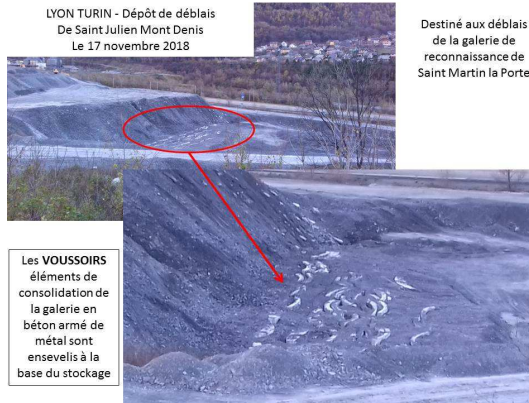
Déblais et dépôts
