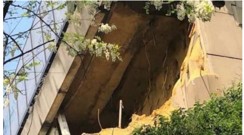
Viaduc de Gennevilliers : le pont s'affaisse, l'autoroute A 15 fermée
