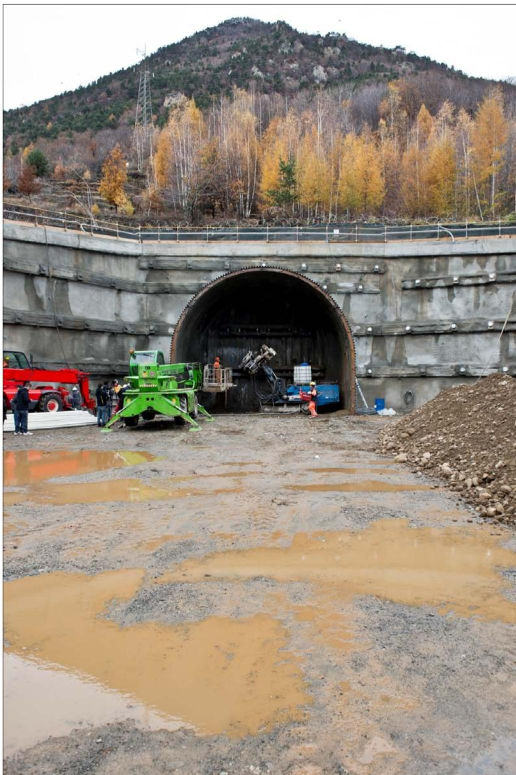
*LTF - chantier de La Maddalena : Vue du gabarit d'attaque de la galerie avant creusement au-delà de la paroi berlinoise*
