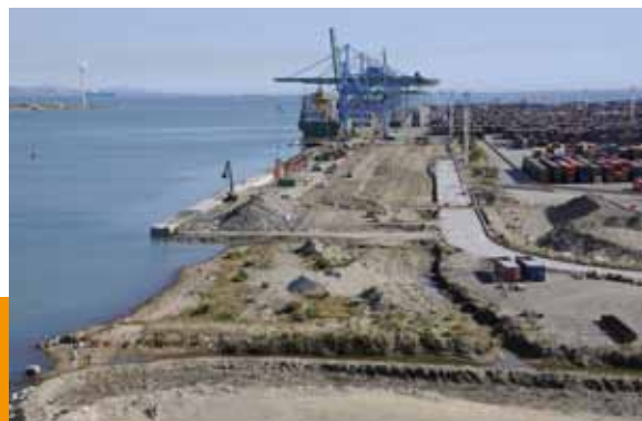
1,2 • Le projet Fos 2XL est réalisé pour le Port autonome de Marseille.
