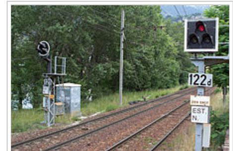
Signalisation italienne et caténaire 3000 V sur la section entre Modane et le tunnel du Fréjus.
